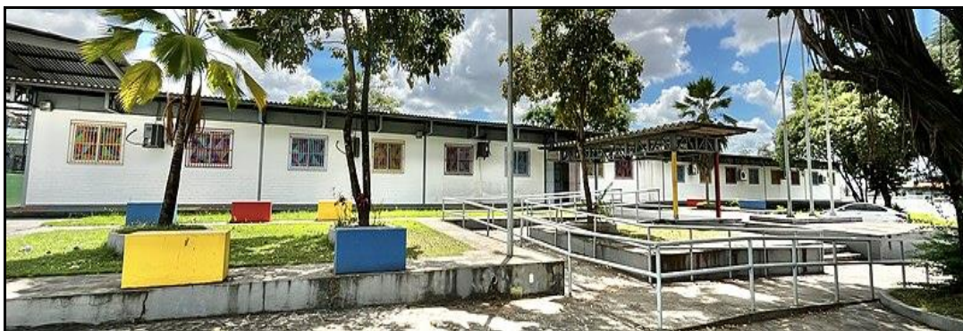
Figura 2 - Imagem da fachada do prédio IEMA Pleno Bacelar Portela
