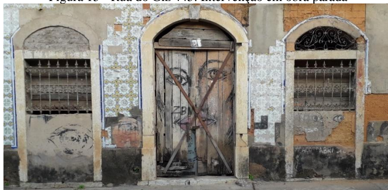
Figura 15 - Rua do Giz 445: Intervenção em obra parada
