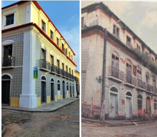
Figura 19 - Comparação fachada Rua do Giz, 445 em 2021 e 1985
