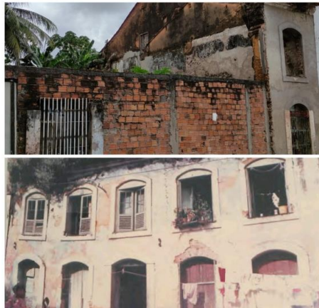
Figura 17 - Comparação fachada Rua do Giz, 405 em 2021 e 1985
