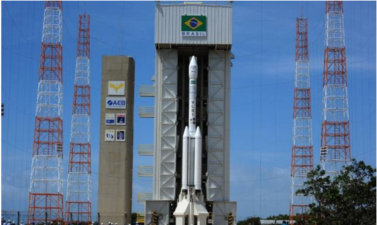
Figura 1: Foto da Torre Móvel de Integração do CLA
