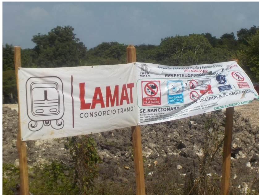
Figura 47: Construcción del Tramo 1 Palenque-Escárcega del Tren Maya Foto: Marcela Orozco
