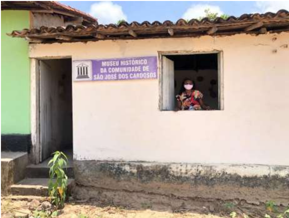
Figura 5 - Fachada e interior do Museu Histórico do povoado de São José dos Pretos em Central-MA
