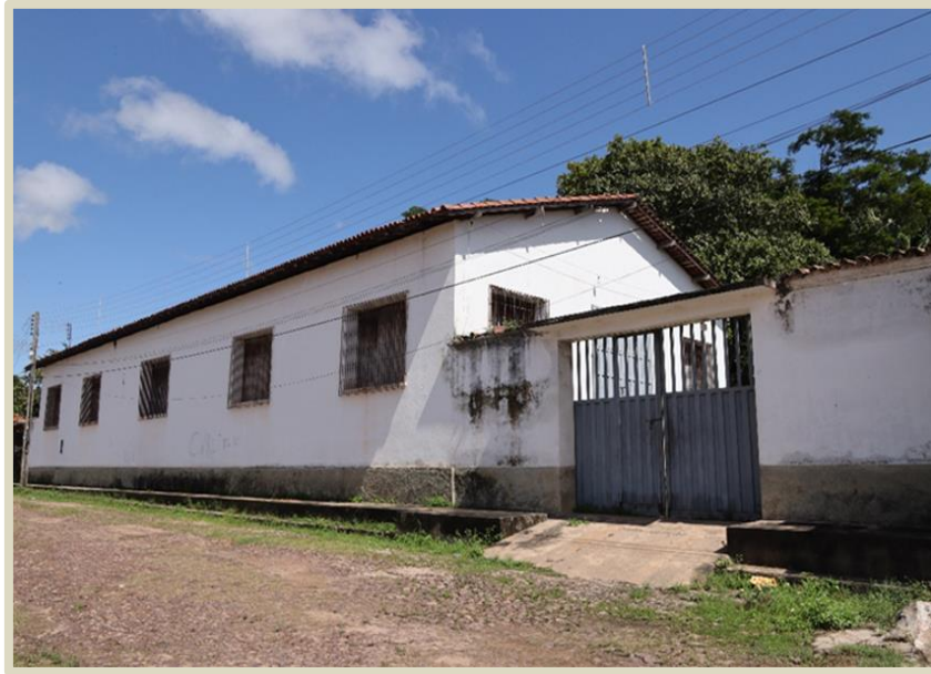
Imagem 6: Prédio construído para instalação da usina elétrica.
