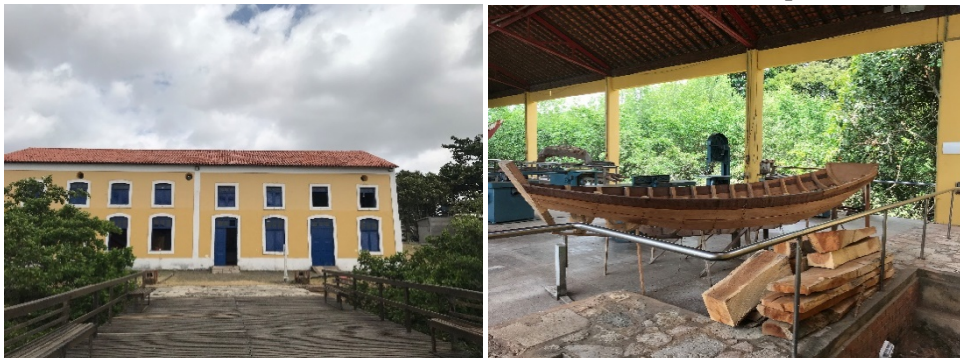
Figura 46 - Edificação reformada e oficina de embarcações artesanais típicas do Maranhão.
