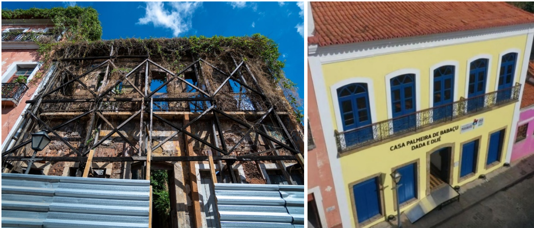
Figura 25 - Fotos antes e depois do casarão restaurado na Rua da Palma
