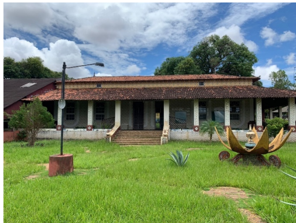
Figura 50 - Área superior: Casa de Moradia
