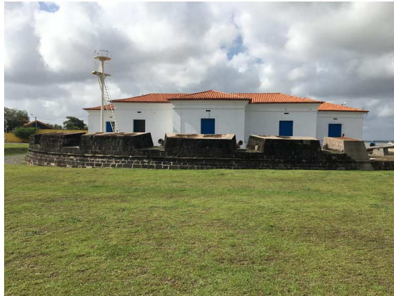
Figura 31 – Forte de Santo Antônio da Barra, 2022
