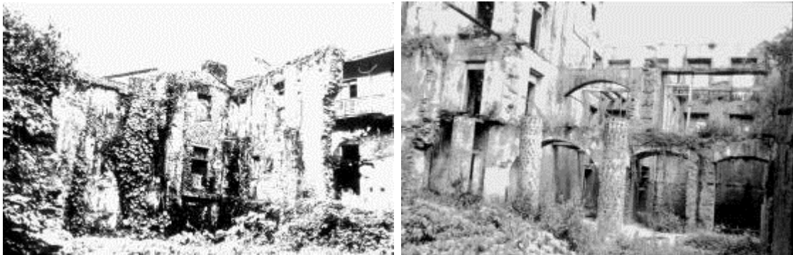
Figura 9 - Imagens de ruínas no período de abandono.
