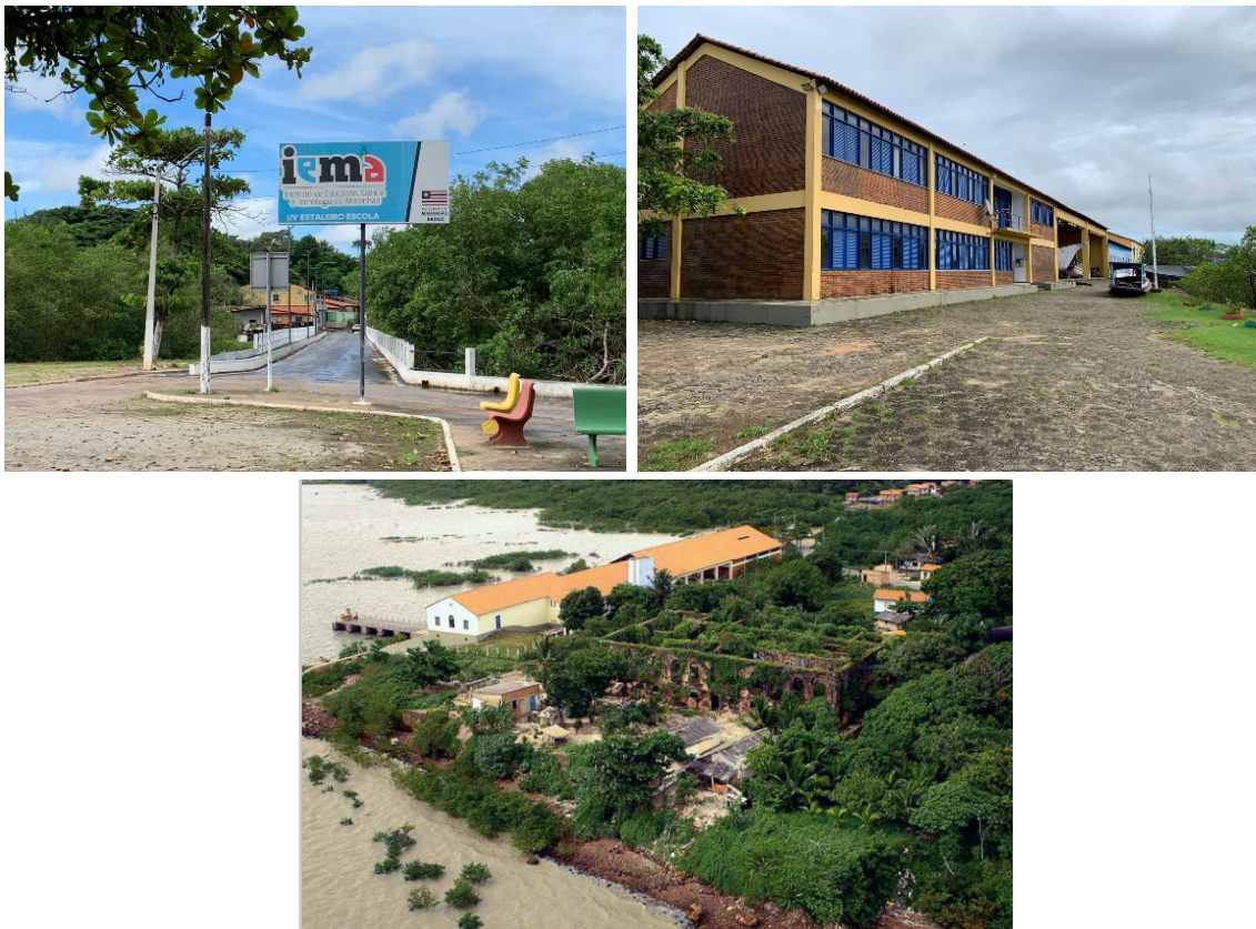
Figura 44 - Entrada, fachada e vista aérea do Sítio Tamancão
