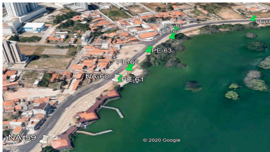
Figura 10 - Área contínua de pontos de esgoto 2
