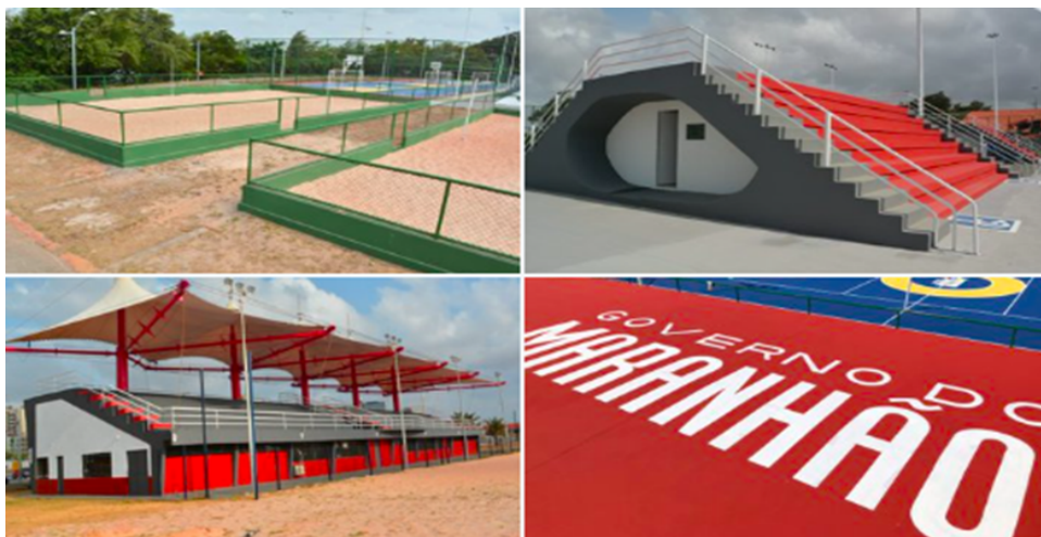
Figura 16 - Obras de revitalização do Pq. Ecológico Laguna da Jansen (parte esportiva)
