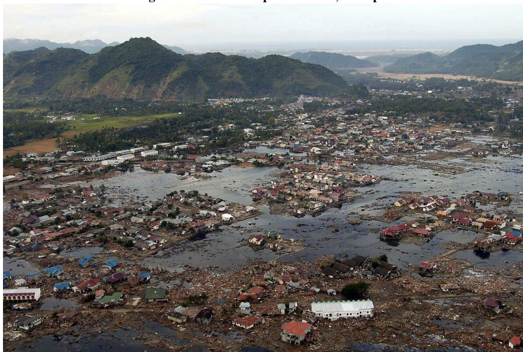
Figura 03 - Sumatra após Tsunami, no Japão
