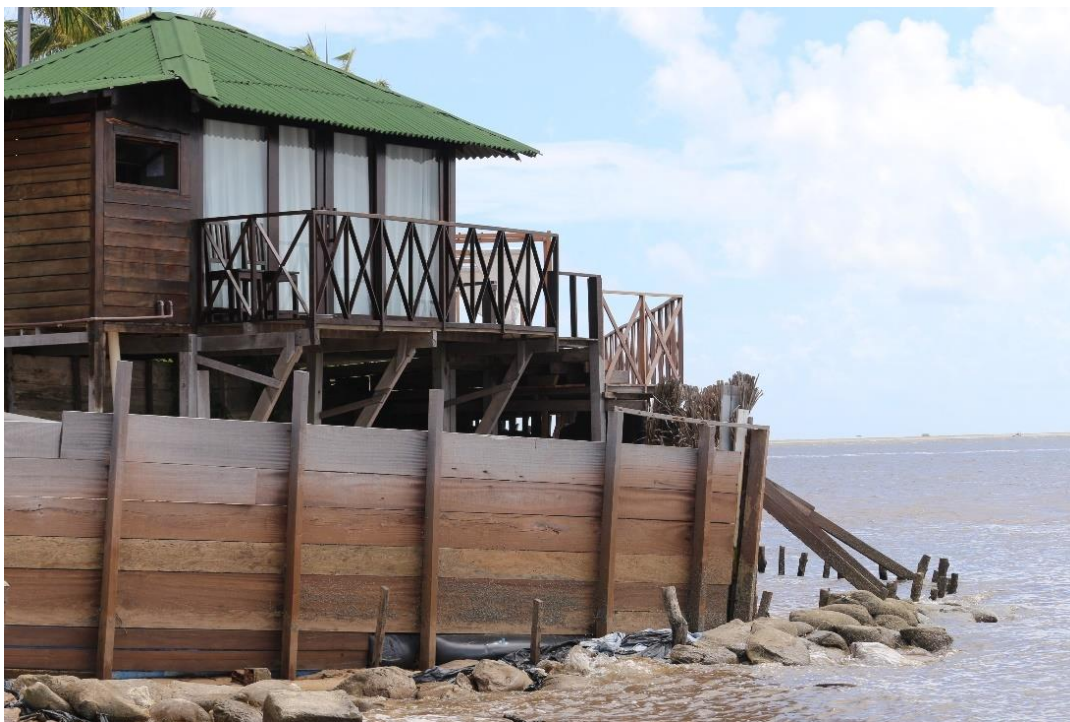
Foto 23 – Pousada construída a beira da praia em Atins sendo invadida pelo mar
