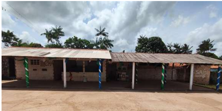
Figura 39 – Centro Comunitário de Damásio.
