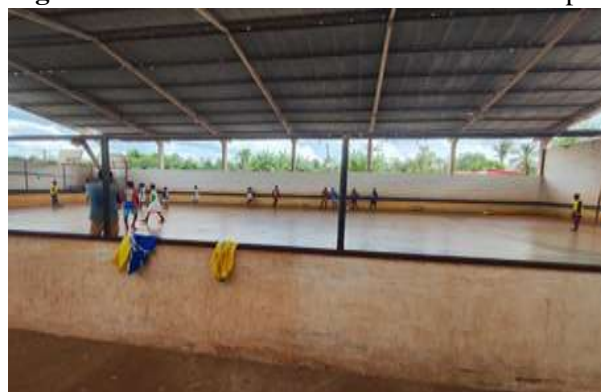
Figura 34 - Estrutura interna do Ginásio Poliesportivo Helvécio Braga.
