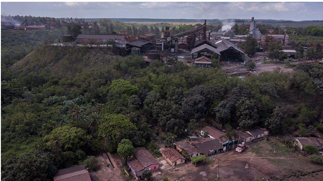
Figura 04 – Siderurgia Gusa Nordeste, instalada no Polo Siderúrgico de Açailândia – MA.
