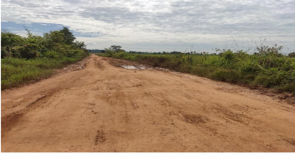
Figura 3 - Trecho da estrada que dá acesso ao povoado Embiral após período do inverno
