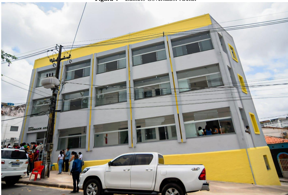
Figura 4 - Edifício Governador Archer
