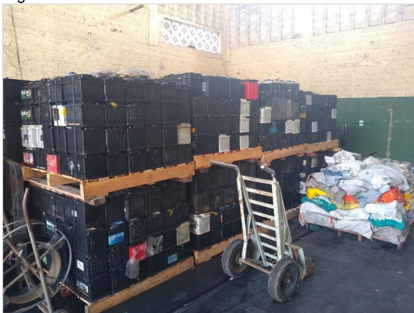
Figura 20 – Armazenamento de baterias inservíveis
