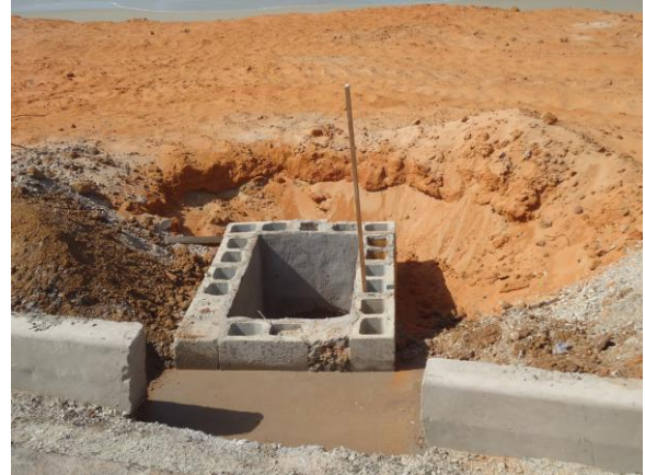
Figura 33: Obras prolongamento da Litorânea Fonte: Dados da pesquisa
