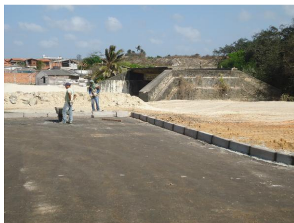
Figura 41: Final do trecho – Rua das Cegonhas
