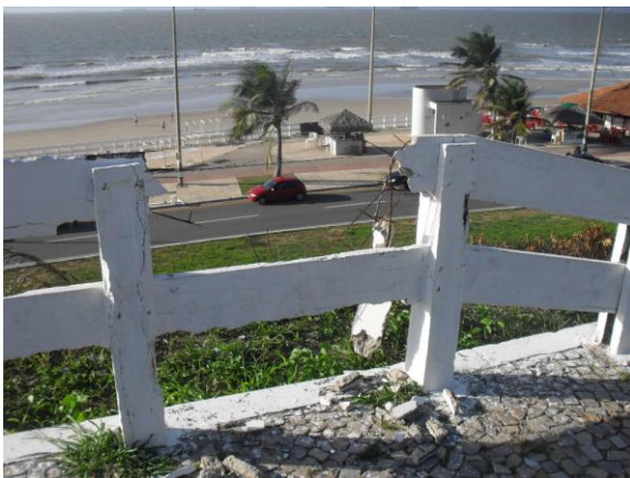
Figura 14: Mureta de proteção Fonte: Dados da pesquisa
