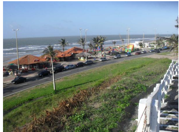
Figura 15: Mureta de proteção Fonte: Dados da pesquisa
