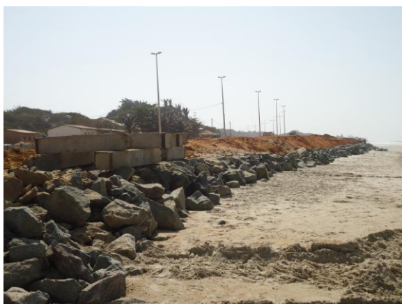
Figura 42: Instalação da iluminação
