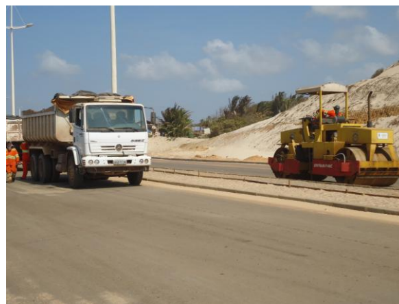
Figura 31: Obras prolongamento da Litorânea Fonte: Dados da pesquisa
