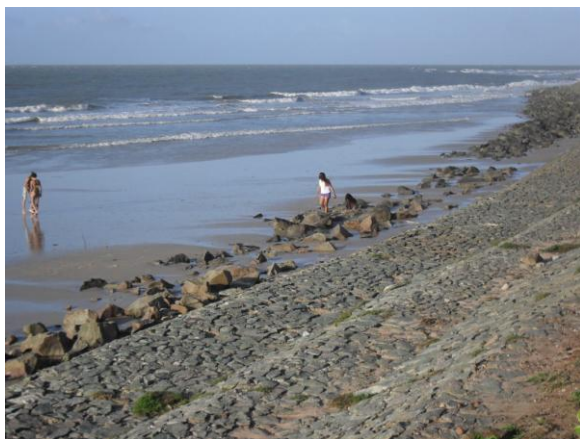
Figura 52: Trecho da avenida sem barracas
