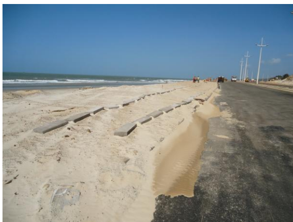
Figura 30: Obras prolongamento da Litorânea Fonte: Dados da pesquisa
