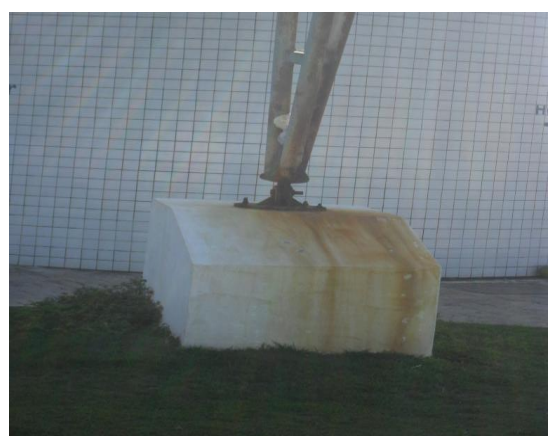
Figura 19: Estrutura cobertura anfiteatro Fonte: Dados da pesquisa
