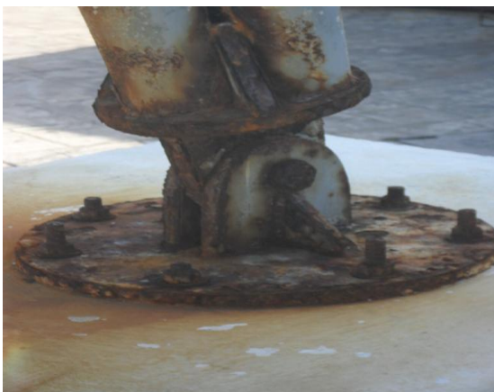
Figura 18: Estrutura cobertura anfiteatro Fonte: Dados da pesquisa
