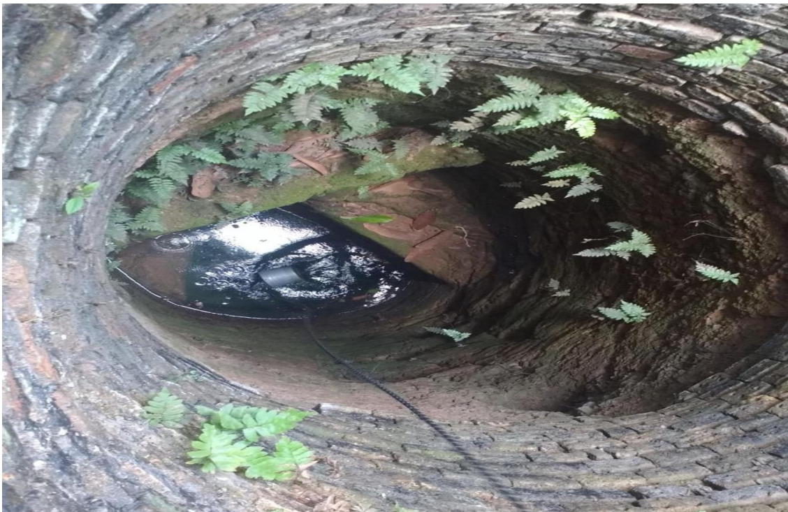
Figura 12- Poço raso construído em quintal de residência.
