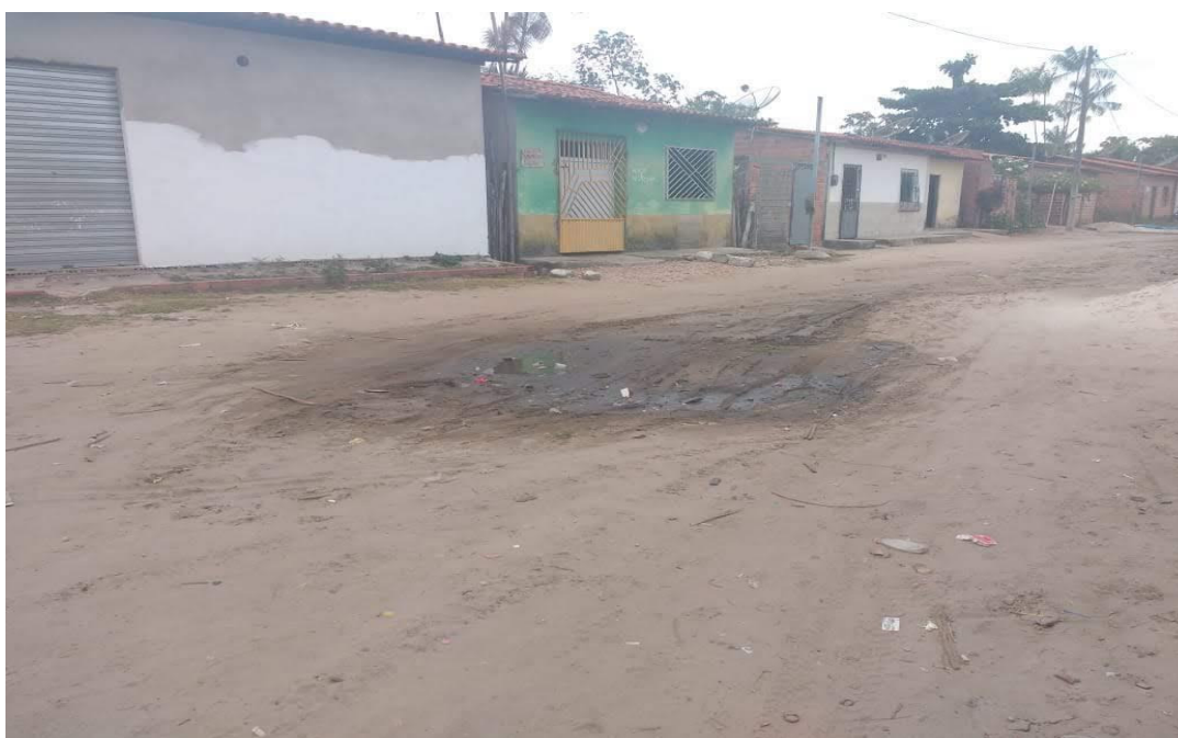
Figura 15 - Rua sem pavimentação no município de Monção.
