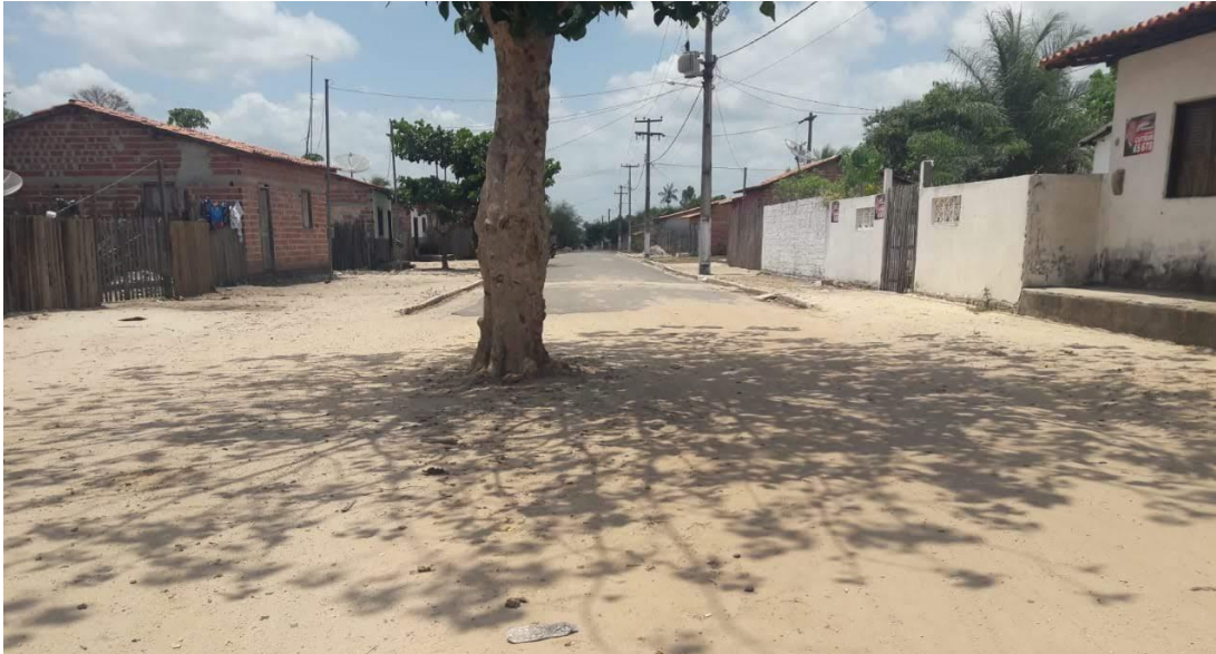
Figura 16 - Rua com pavimentação limitada no município de Monção.
