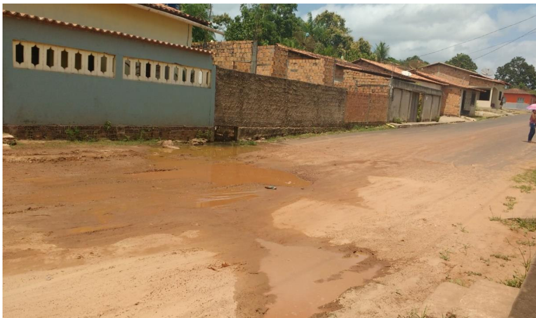
Figura 10 - Esgotamento a céu aberto no município de Matinha.
