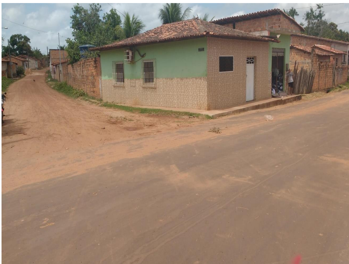
Figura 09 - Ausência de pavimentação em ruas de Matinha.
