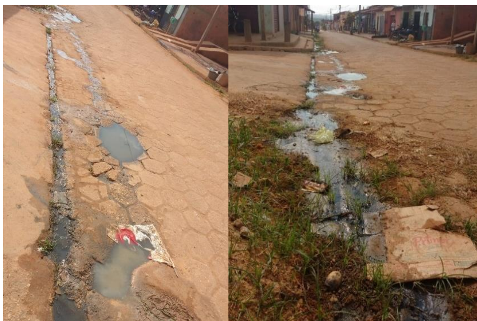
Figura 8: Esgoto nas ruas de Buriticupu – MA, 2018
