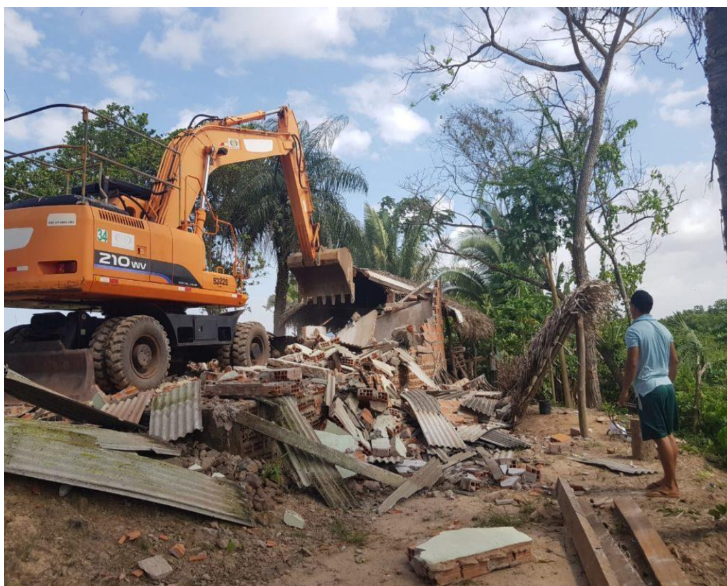
Figura 9 - Casas sendo derrubadas na comunidade Cajueiro.
