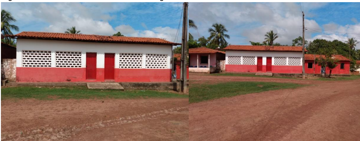
Figura 24: Prédio do anexo da Unidade Integrada Pontal
