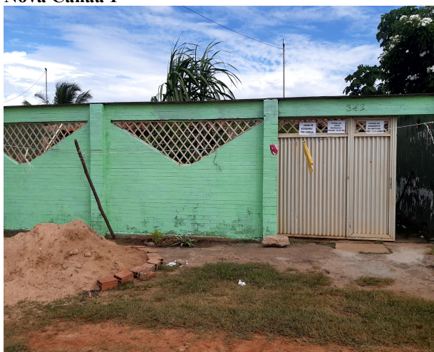
Figura 11 - Casa com estrutura alterada na Nova Canaã 1
