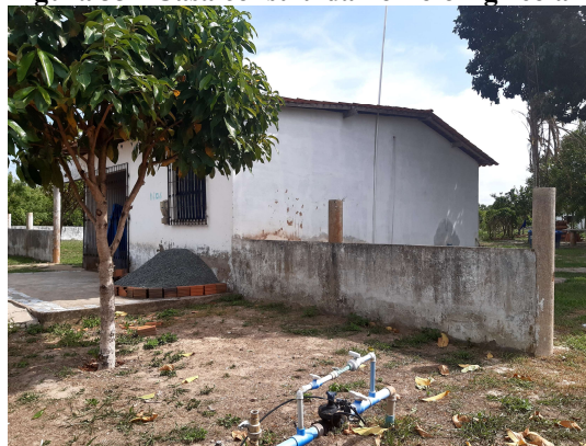
Figura 33 - Casa construída no Polo Agrícola 4
