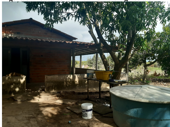
Figura 31- Casa construída no Polo Agrícola 3
