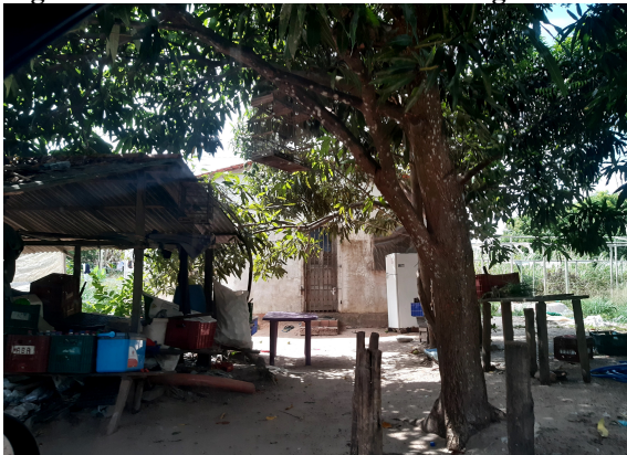
Figura 34 - Casa construída no Polo Agrícola 5
