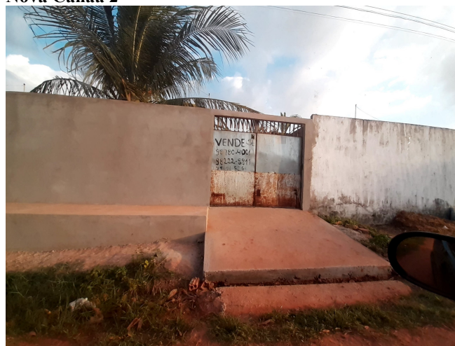
Figura 12 - Casa com estrutura alterada na Nova Canaã 2
