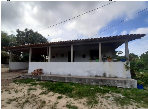
Figura 30 - Casa construída no Polo Agrícola 1
