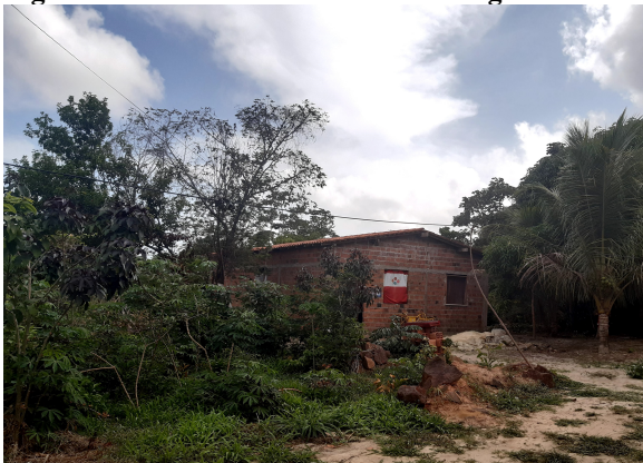
Figura 32- Casa construída no Polo Agrícola 2
