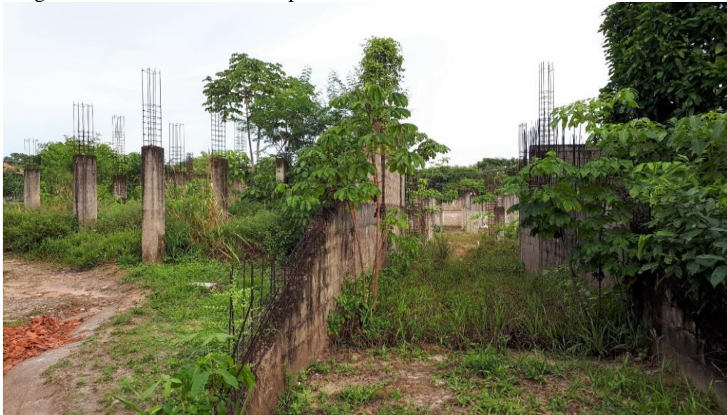
Figura 10- Estrutura inicial do prédio sede da SEMA
