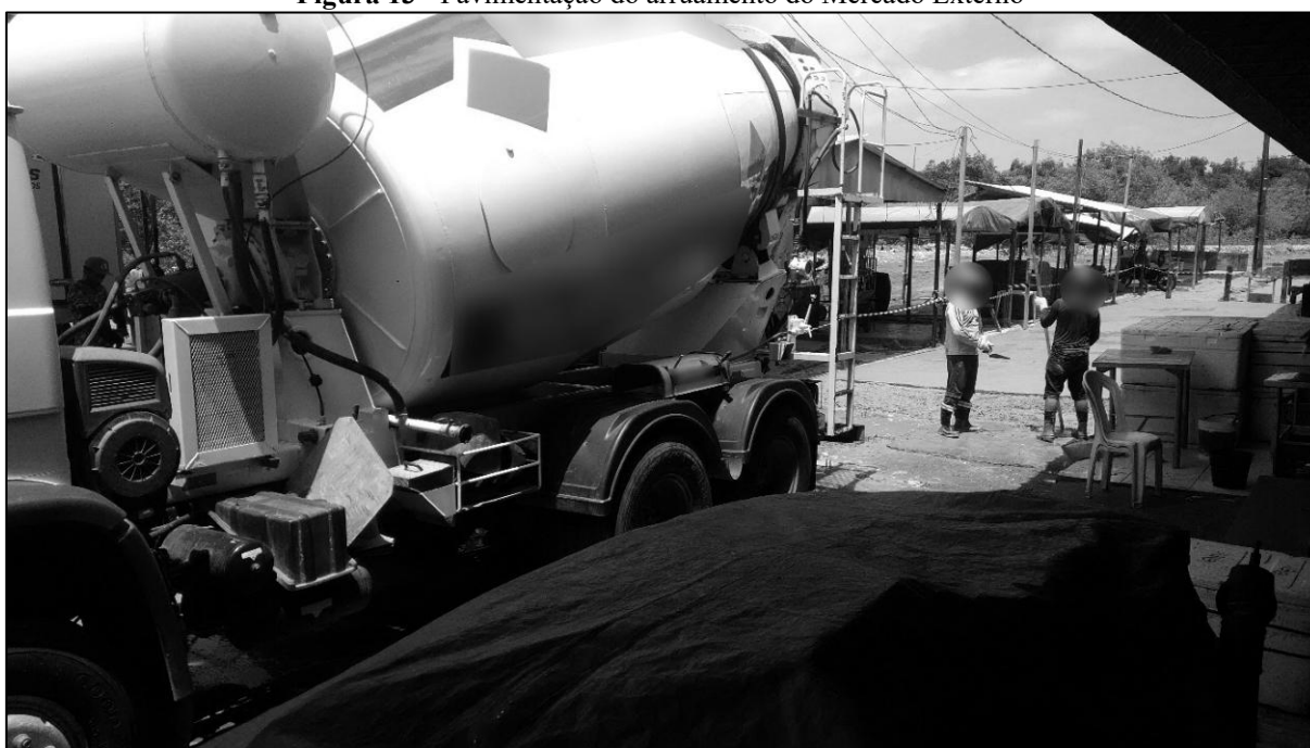
Figura 13 - Pavimentação do arruamento do Mercado Externo
