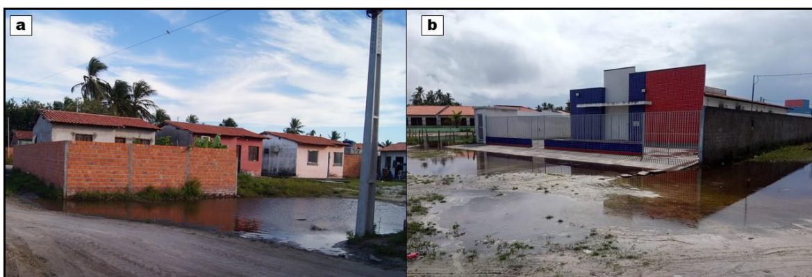
Figura 50: Pontos de alagamento no bairro Alto Formoso: a- Conjunto Habitacional; b- Restaurante Popular.
