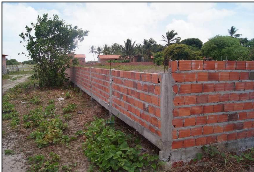
Figura 44: Vista parcial de muro com base vazada, próximo ao lago de Santo Amaro.
