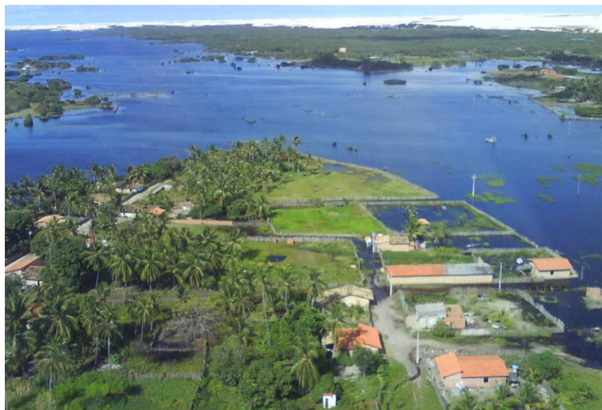
Figura 32: Vista aérea da porção Leste do bairro Alto Formoso inundada em 2009
