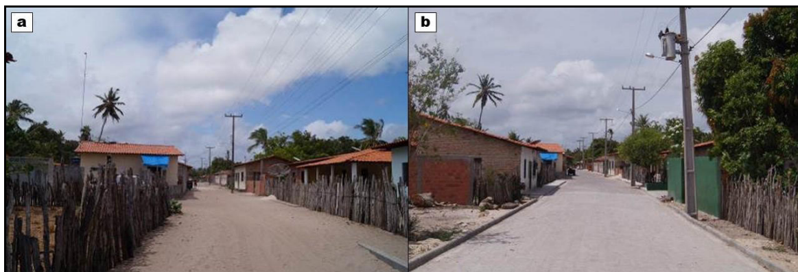
Figura 38: Avanço da pavimentação no bairro Alto Formoso.
