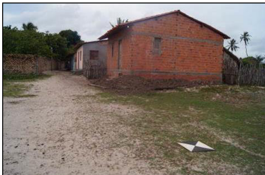
Figura 45: Casa com base mais elevada, situada na margem do lago de Santo Amaro.
