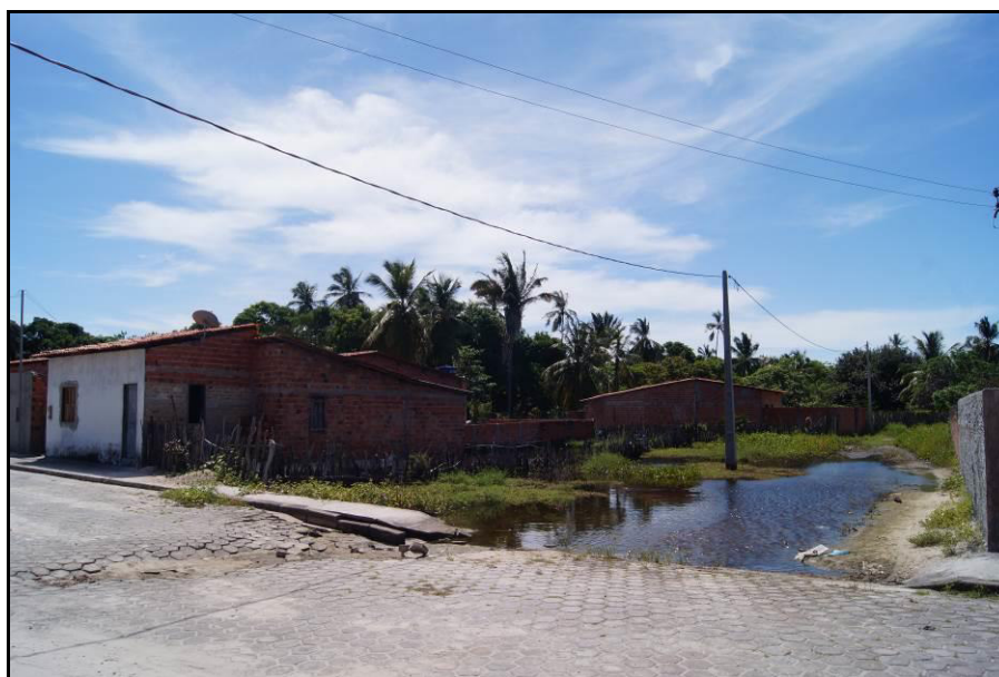
Figura 49: Canaleta direcionando o fluxo do escoamento superficial para via transversal.
