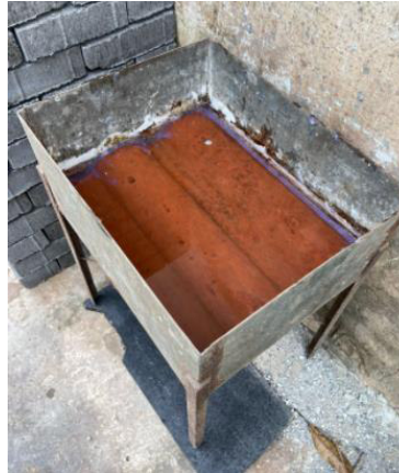
Figura 21: Ensaio de impermeabilidade
