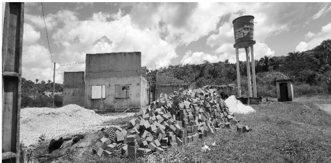
Figura 5 - Escola Digna em construção no povoado Jibóia, município de Afonso Cunha
