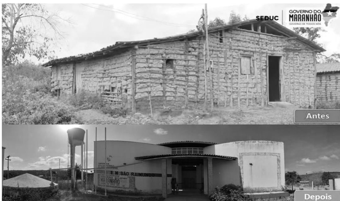
Figura 4 - E. M. São Raimundo antes e depois do Programa Escola Digna, povoado Centro do Chiquinho, município de São Raimundo do Doca Bezerra
