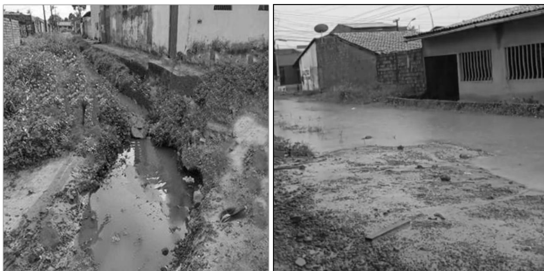
Figura 27 – Condições da infraestrutura – Conjunto Marly Abdalla II
