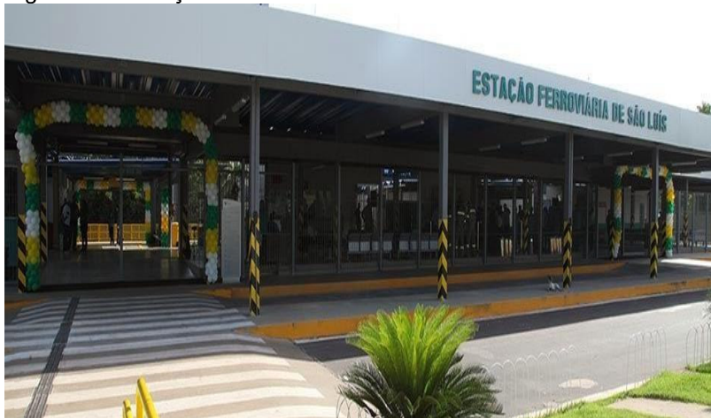
Figura 24 - Estação Ferroviária de São Luís
