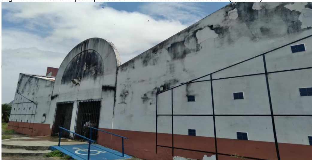
Figura 33 – Entrada principal da UEB Professora Rosália Freire (fachada)
