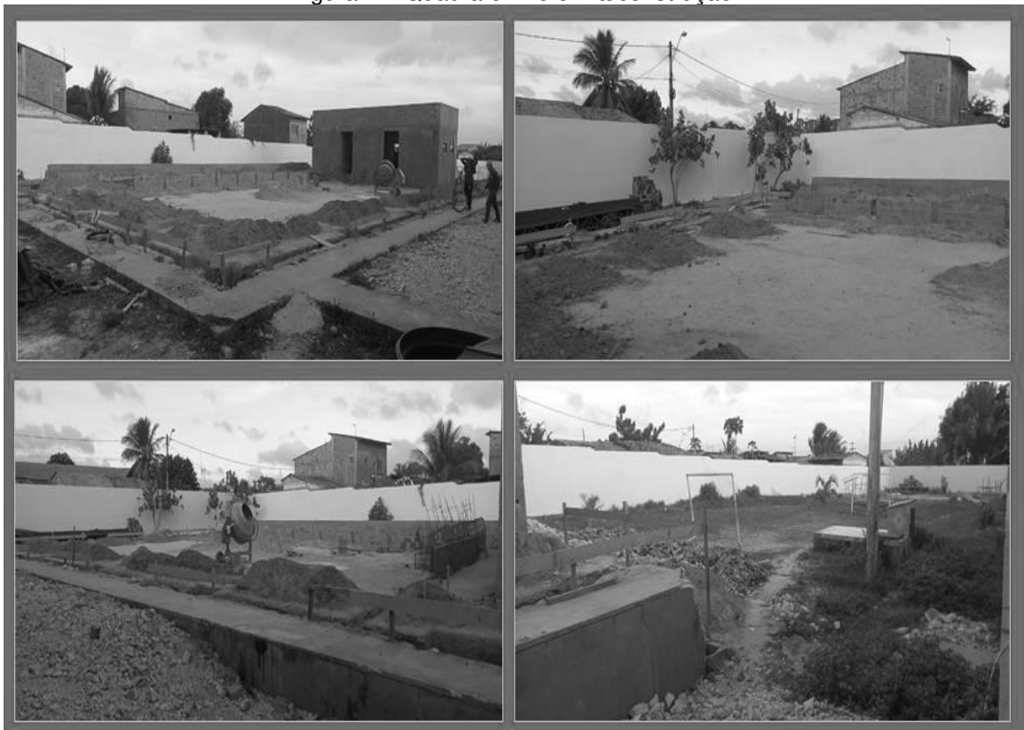
Figura 24: Quadra em reforma/construção.
