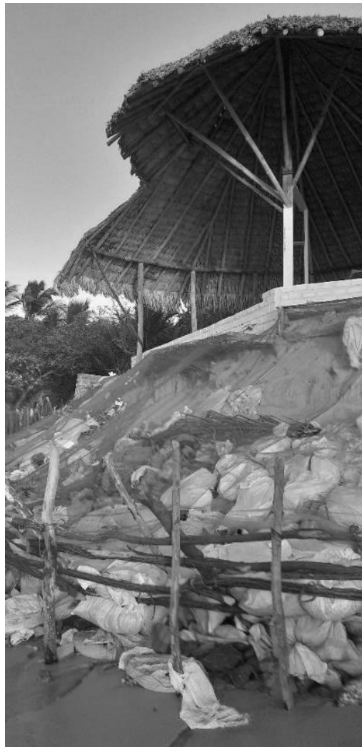
Foto 7: Alguns ranchos de uma pousada destruída pela ação das marés. Autora: Lícia Viana agosto de 2019.
