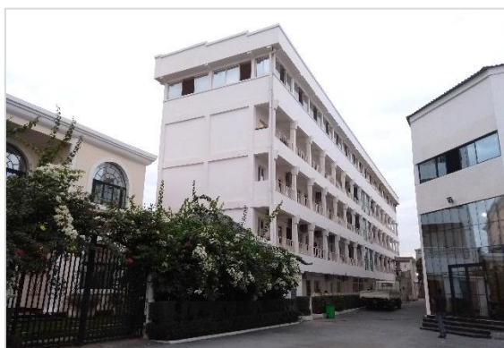
Fig. 42 – Complexo administrativo (ao centro) Foto: Adriano Kilala. 26 abr. 2019
