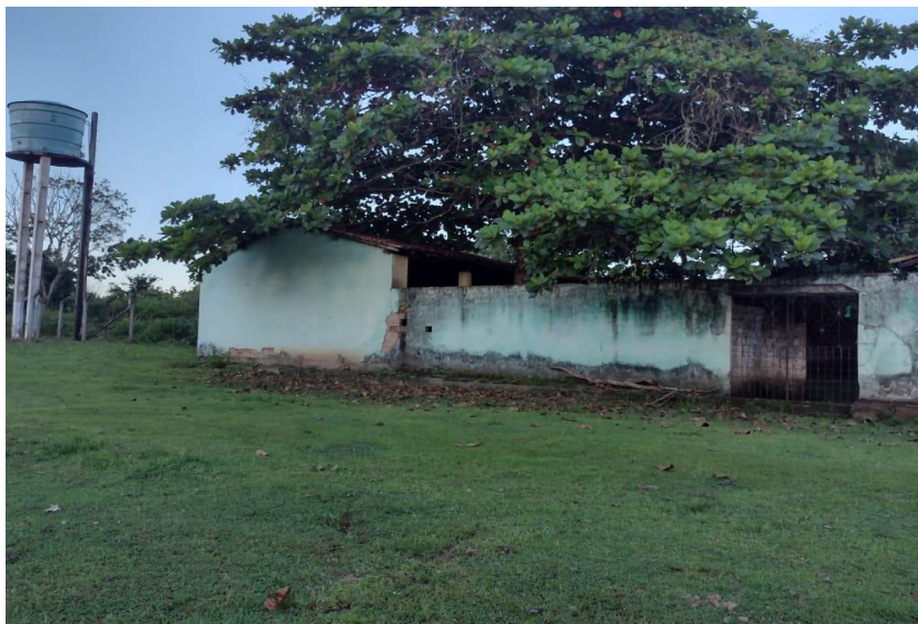
Figura 6 - Sede do MOQUIBOM na comunidade Pau Pombo, ao lado do poço que abastece os moradores.
