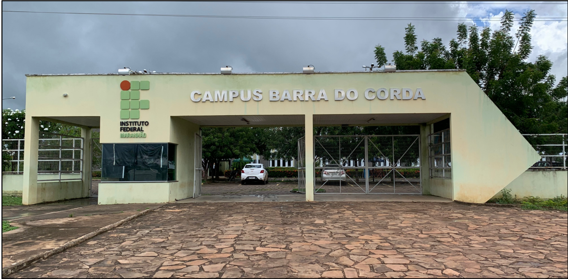
Figura 23. Instituto Federal de Educação, Ciência e Tecnologia do Maranhão Campus Barra do Corda
