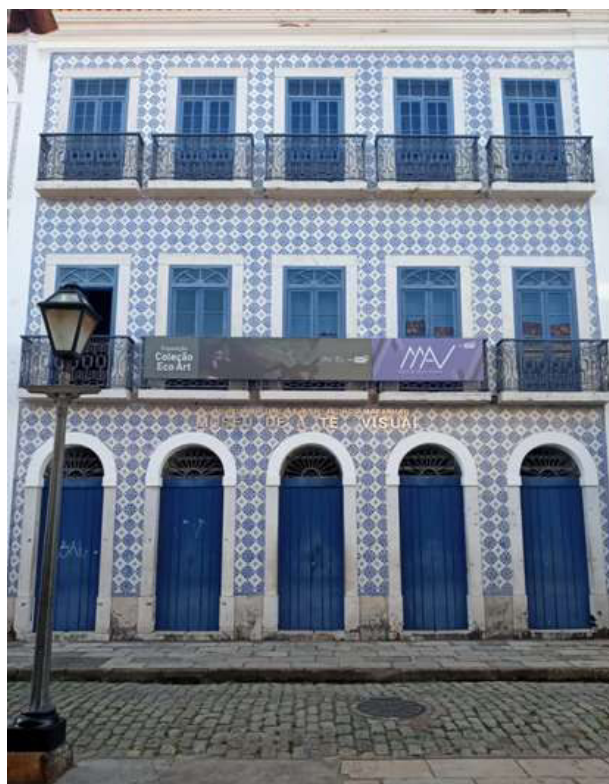
Figura 43 – Fachada de prédio histórico no Centro Histórico de São Luís - MA
