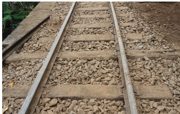
Figura 15 - Processo de colmatação de lastro.
