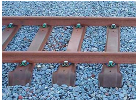
Figura 7 – Exemplo de dormentes de aço suportando trilhos ferroviários.
