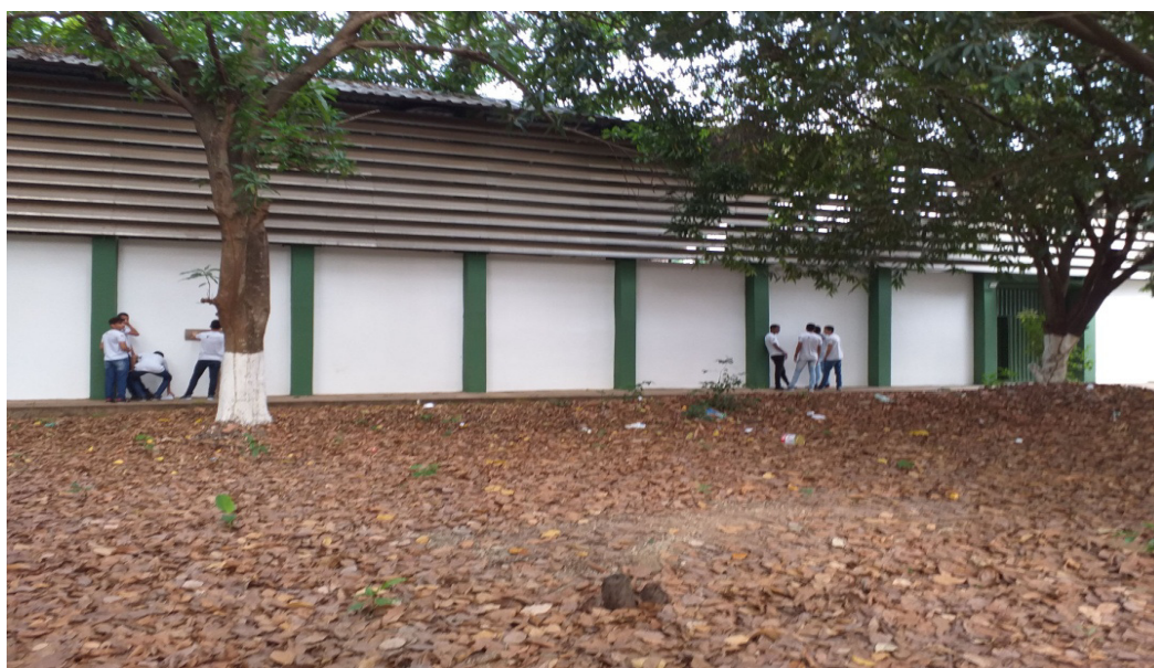
Figura 31: Alunos fazendo observação da parede para intervenção
