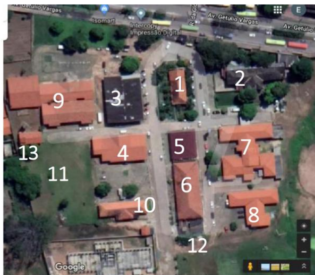
Figura 1 - Espaço físico do Hospital Nina Rodrigues
