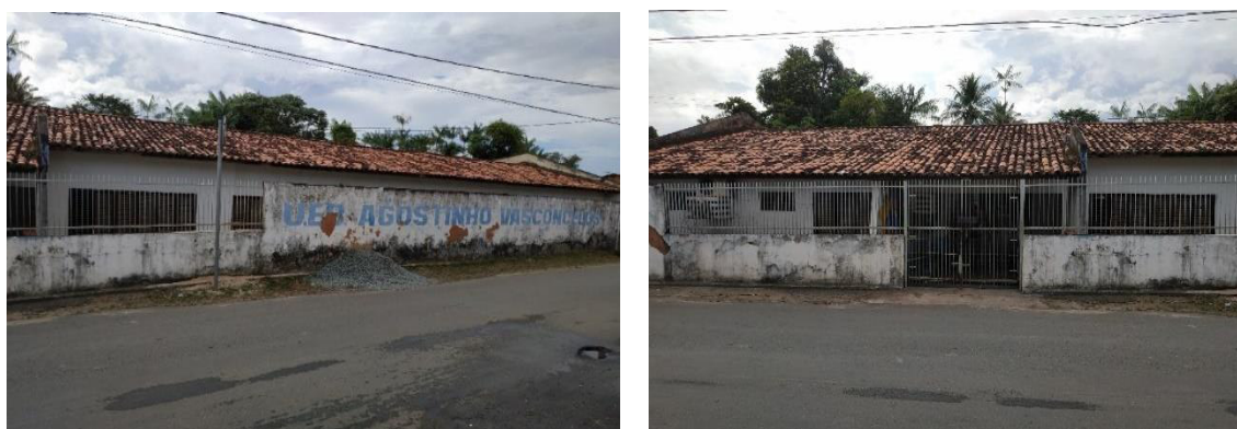
Figura 9: Unidade de Educação Básica UEB Agostinho de Vasconcelos
