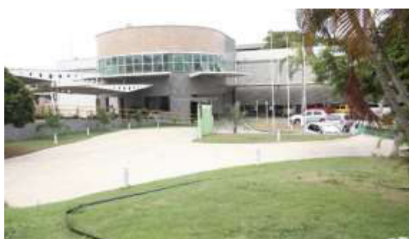
Figura 8 – Fachada do IFMA / Campus São Luís-Monte Castelo.
