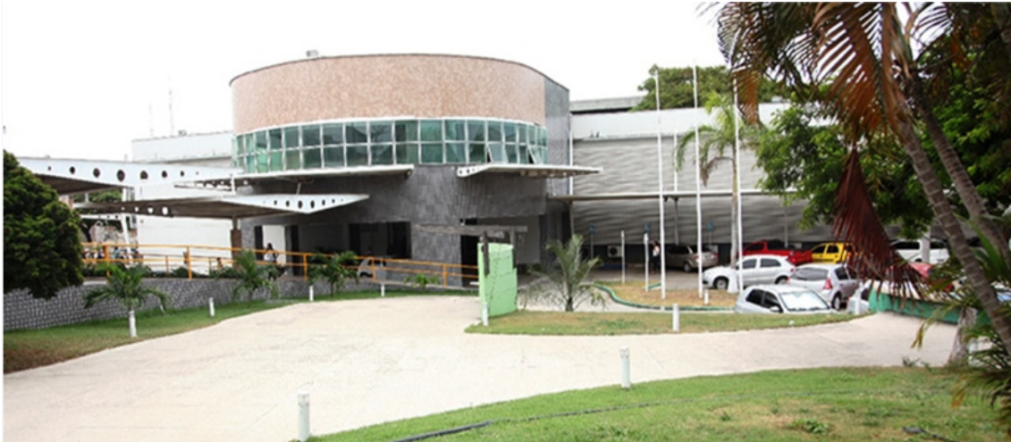
Figura 9 - Fachada do IFMA Campus Monte Castelo
