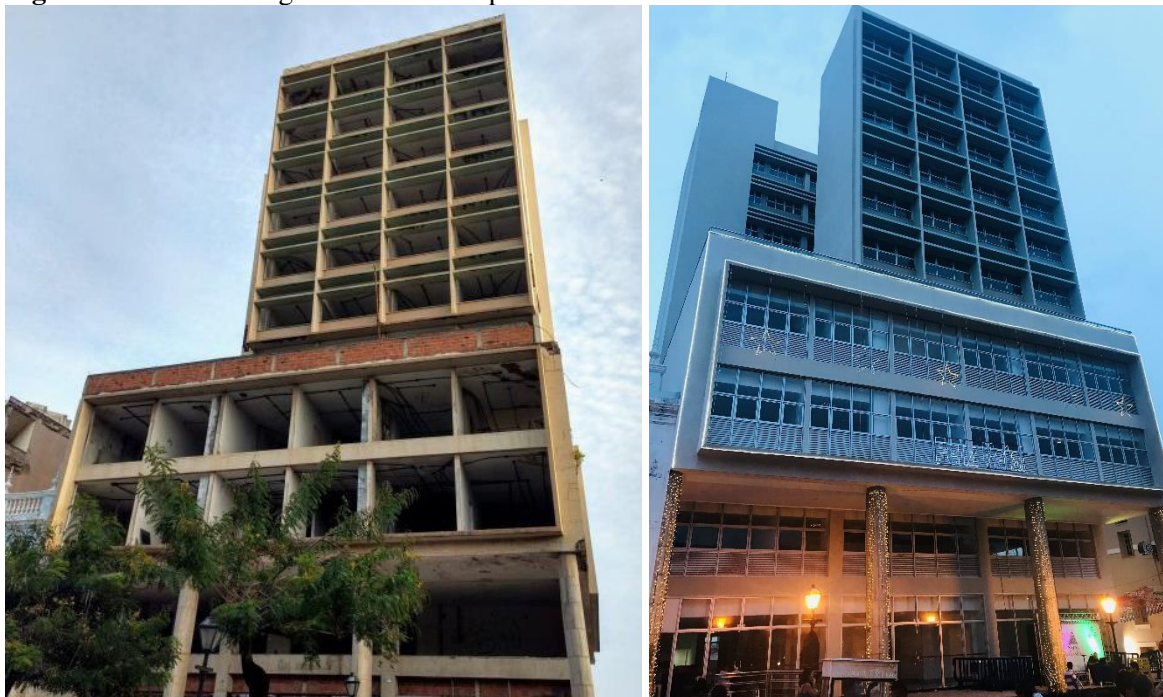
Figura 23 - Fotomontagem do antes e depois da reforma do Edifício João Goulart
