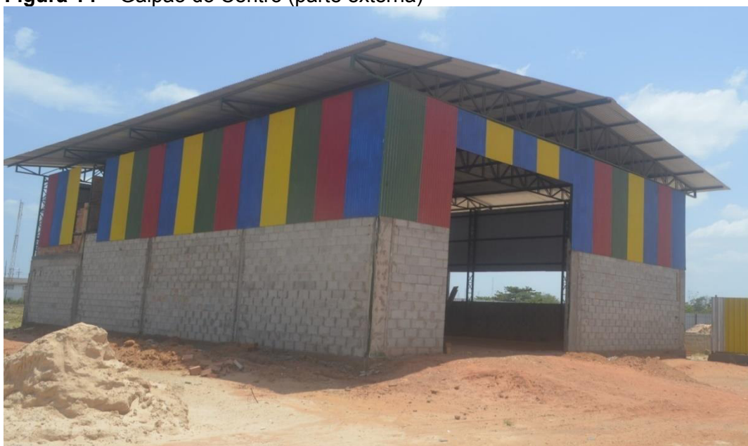
Figura 14 – Galpão do Centro (parte externa)
