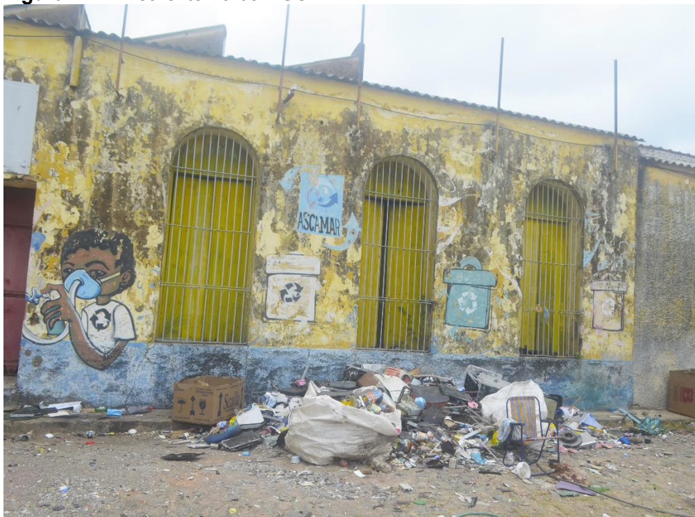
Figura 11 – Área externa da ASCAMAR
