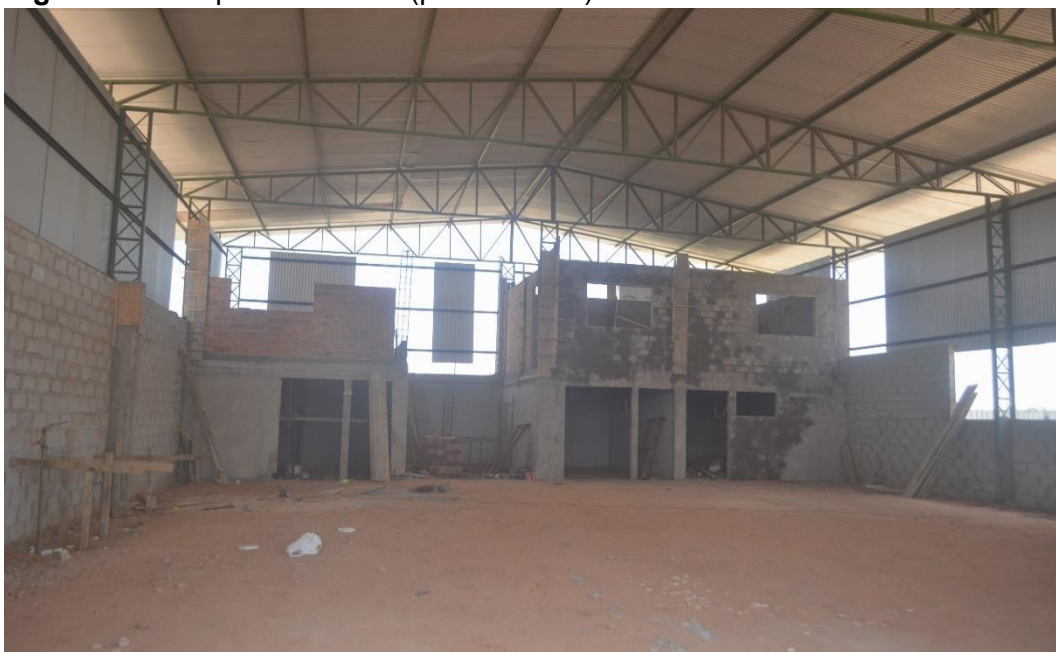
Figura 13 – Galpão do Centro (parte interna)
