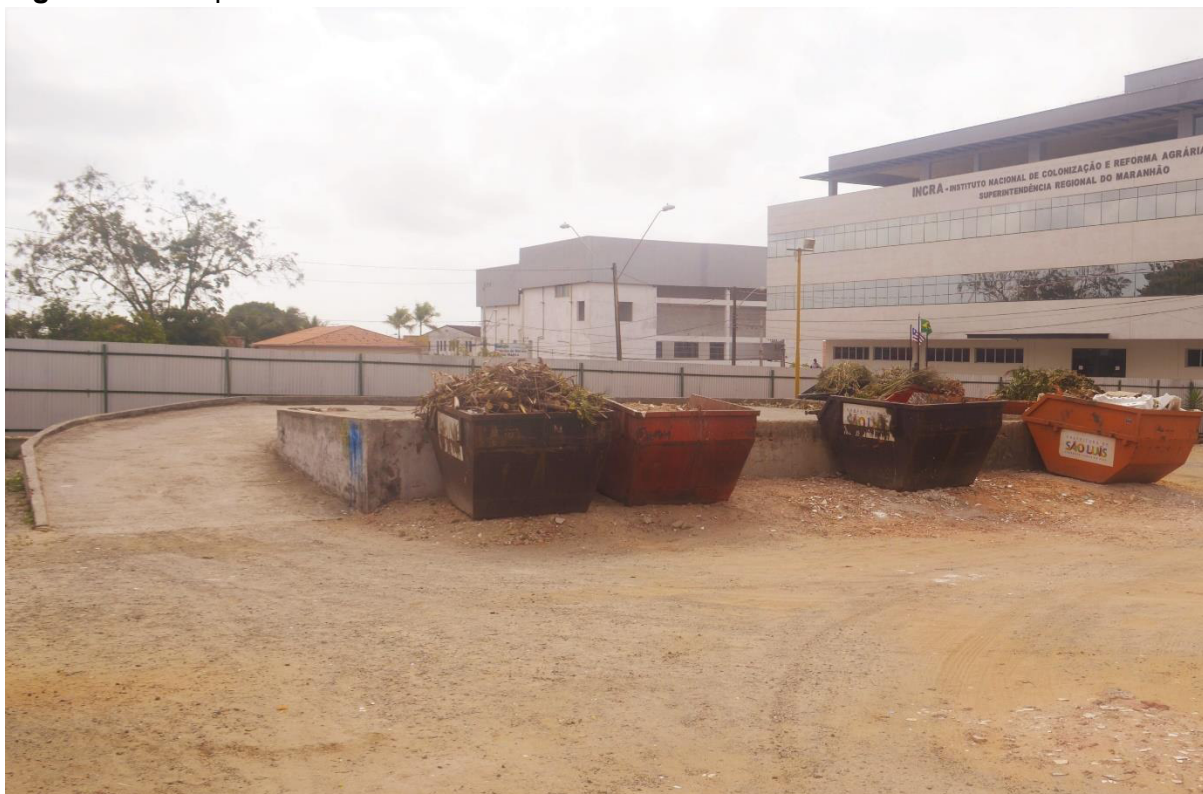
Figura 4 – Rampa de acesso às caixas estacionárias
