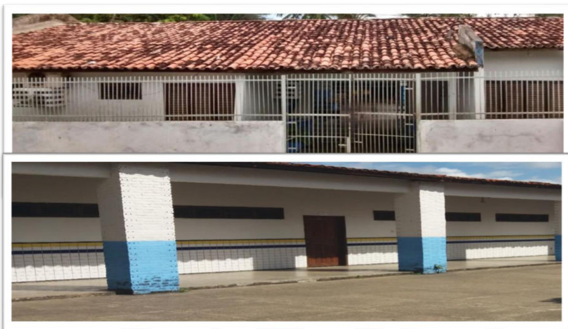
Figura 4 - Unidade de Educação Básica-UEB Agostinho Vasconcelos
