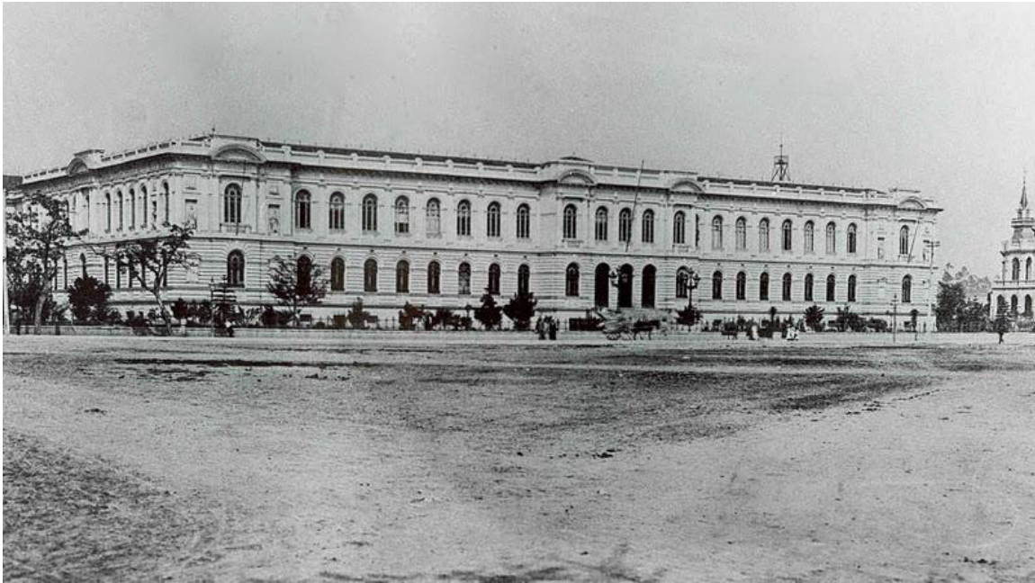
Figura 1 - Fachada da Escola Normal de São Paulo em 1890
