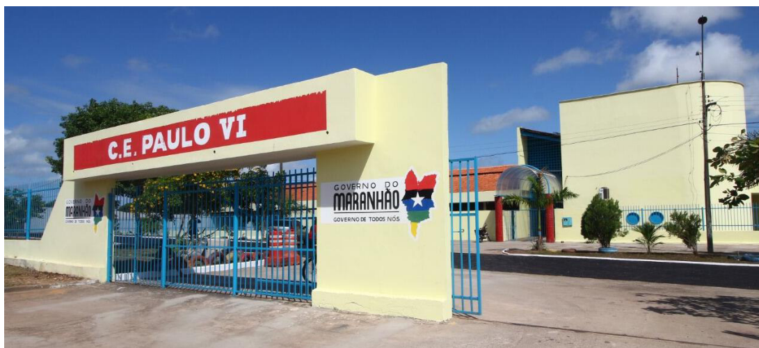
Figura 9: Fachada da escola CE – Paulo VI
