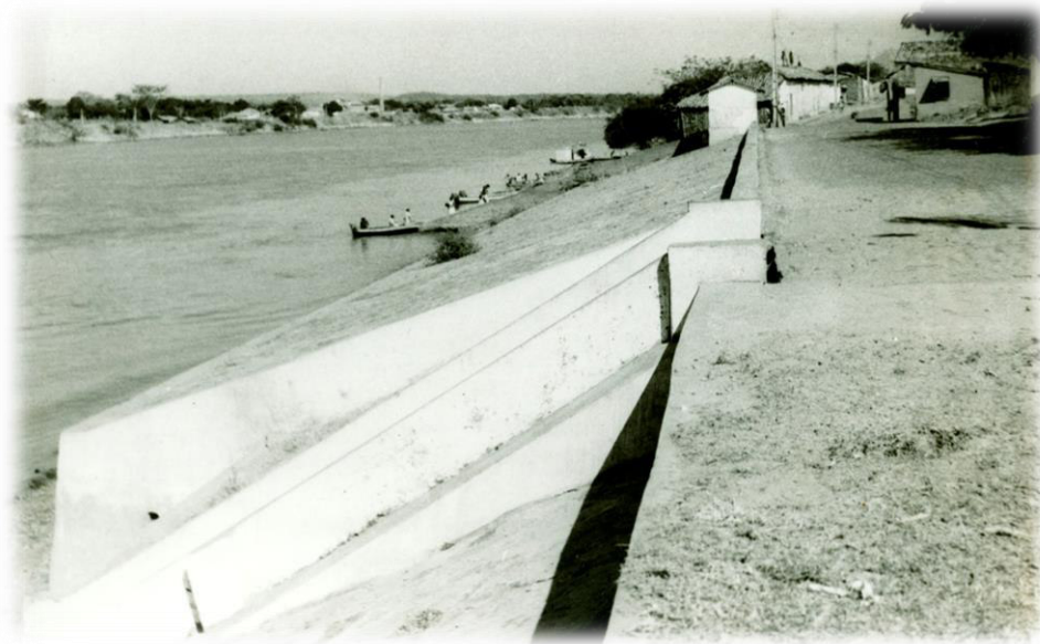
Figura 8: Ponto de embarque construído às margens do rio Parnaíba, no município de Barão do Grajaú. [19--] data provável.
