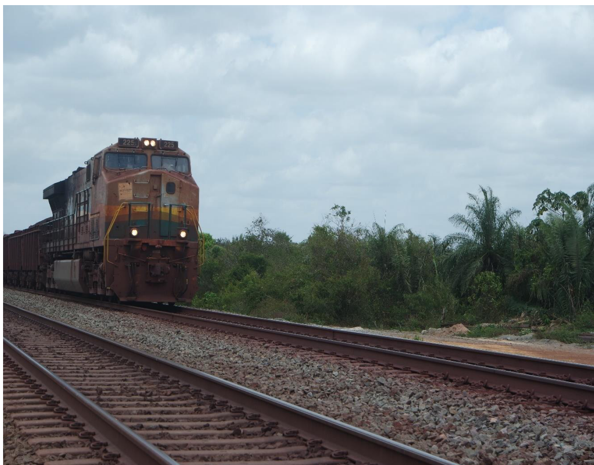
Foto 55: Estrada de Ferro Carajás sobre o Igarapé Simauma
