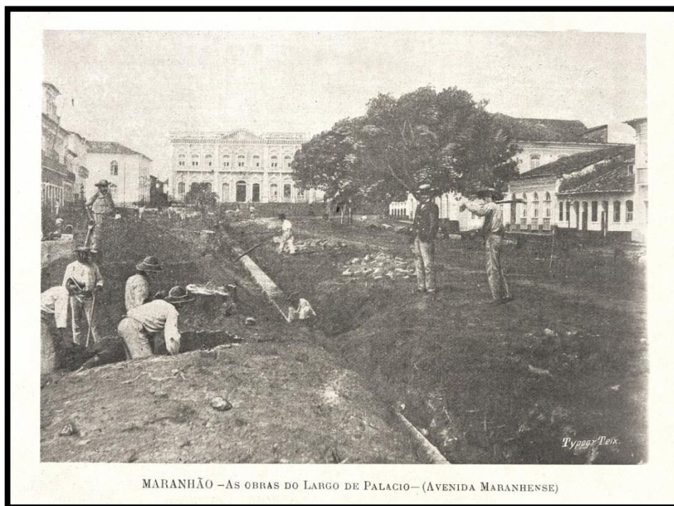
Figura 22 - Obras na Avenida Maranhense, 1.
