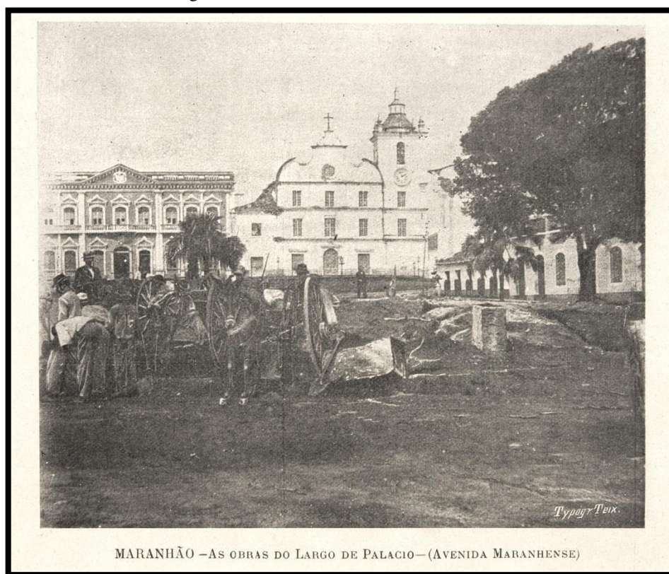
Figura 23 - Obras na Avenida Maranhense, 2.
