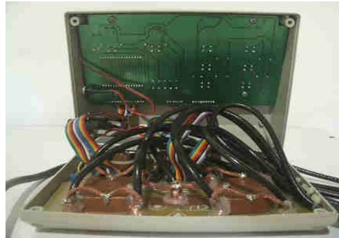
Figura 37 – Aspecto final do lado interno do chaveador.
