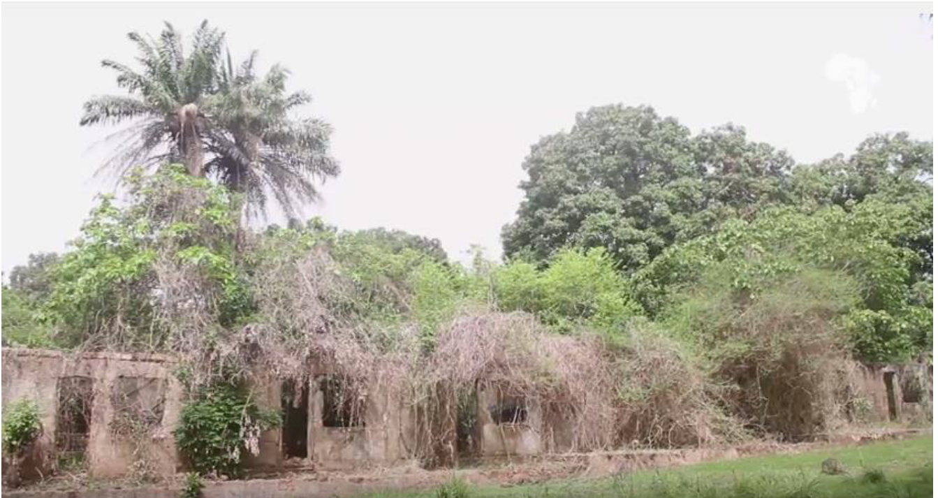
Figura 11 Antiga prisão localizada na Ilha de Loos que servia de repressão dos escravos rebeldes que se mostravam resistentes a essa condição. Fonte: < https://youtu.be/uGhODztt1XI >
